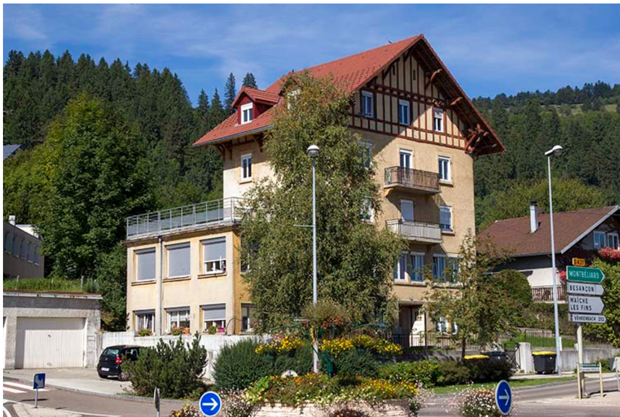
Façades antérieure et latérale gauche.
