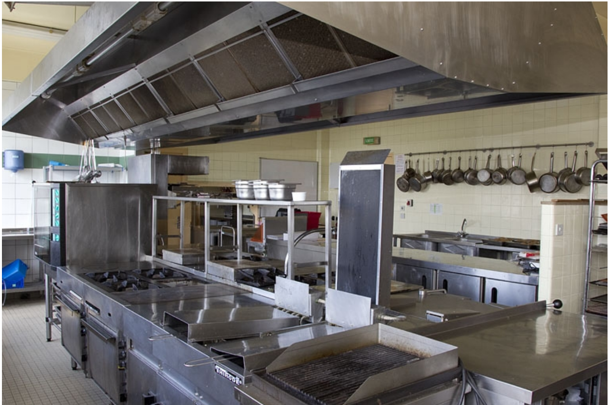
Bâtiment de l'hôtellerie : cuisine pédagogique (nord).
