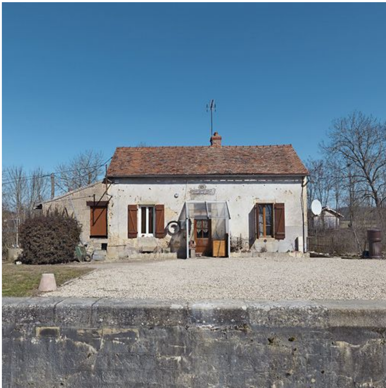
La maison éclusière de face.
