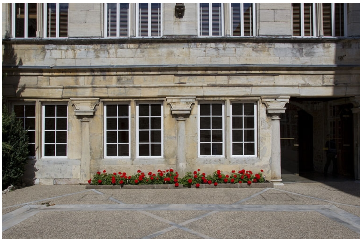
Logis principal : vue d'ensemble du portique.
