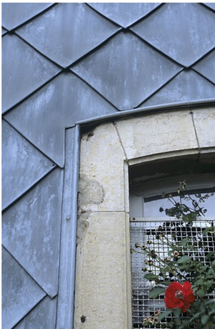
Bâtiment des voyageurs : détail de l'essentage de tôle de l'élévation latérale sud.
