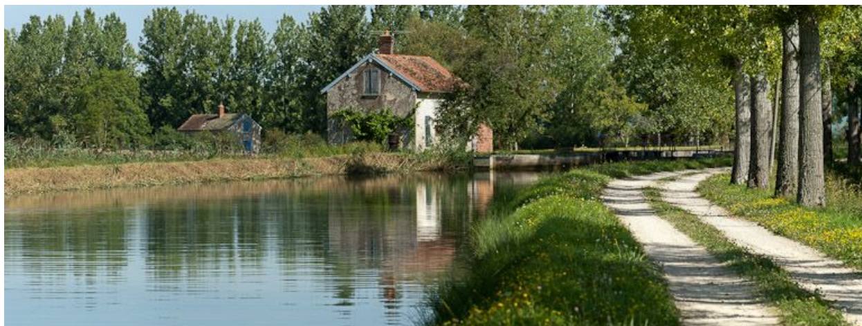
Vue du site d'écluse depuis l'amont.
