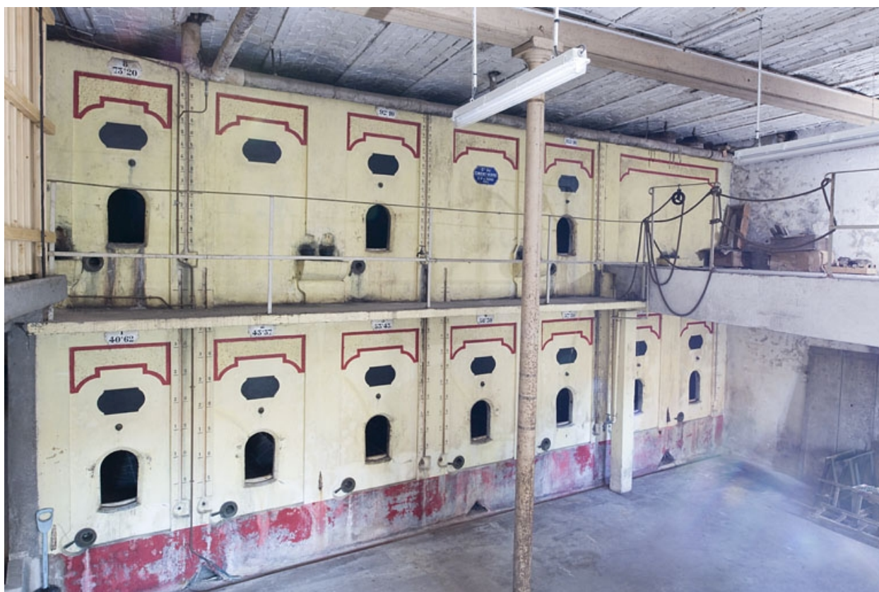
Intérieur de l'entrepôt : vue d'ensemble des caves.
