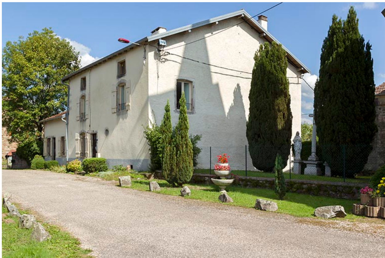
Façades postérieures et latérale sud.
