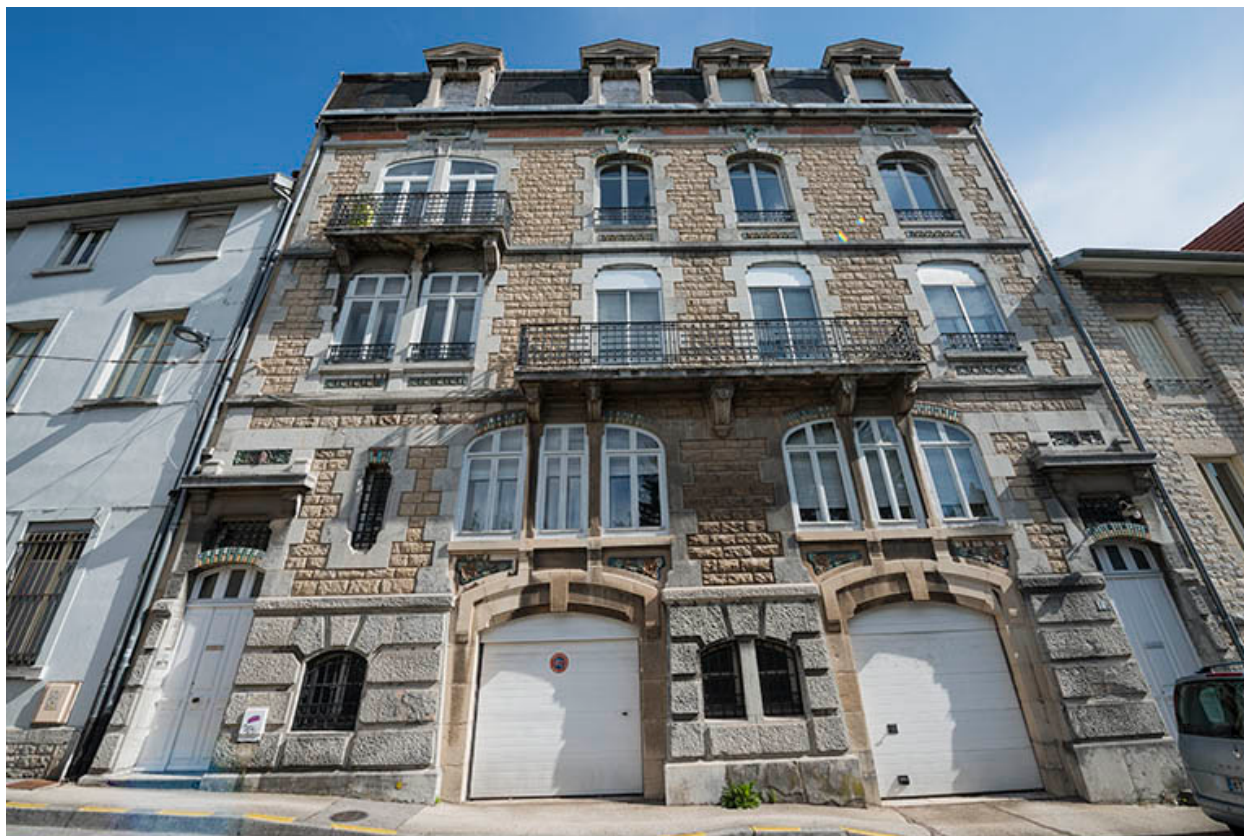
Façade antérieure. Vue en contre-plongée.
