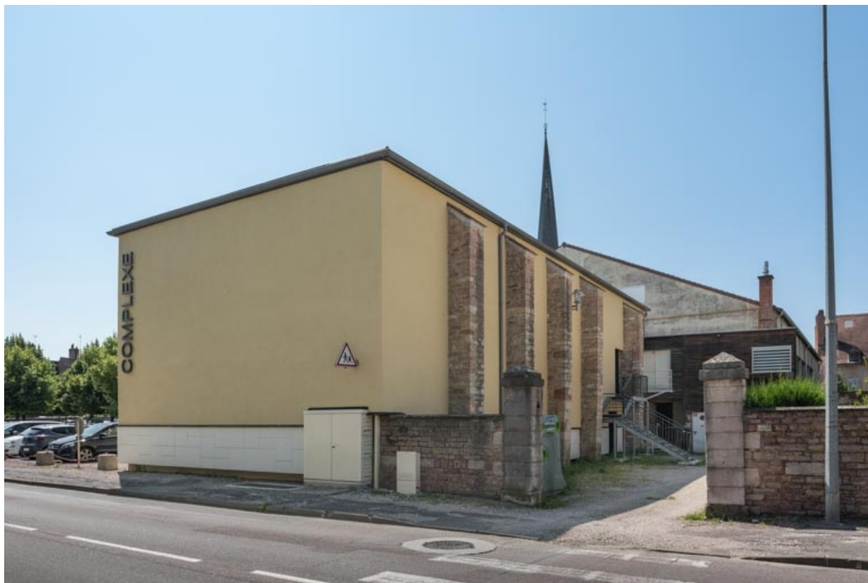
Façades postérieure et latérale droite.
