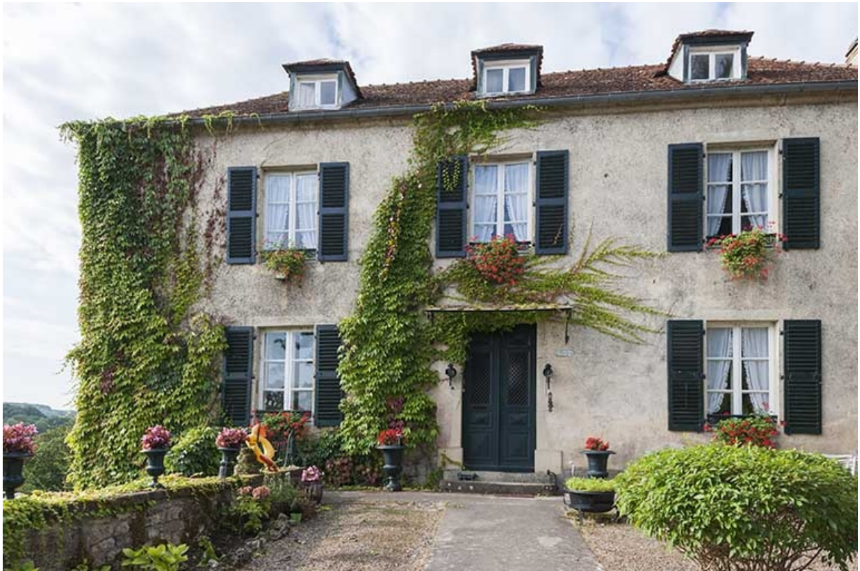
Façade antérieure sur cour.
