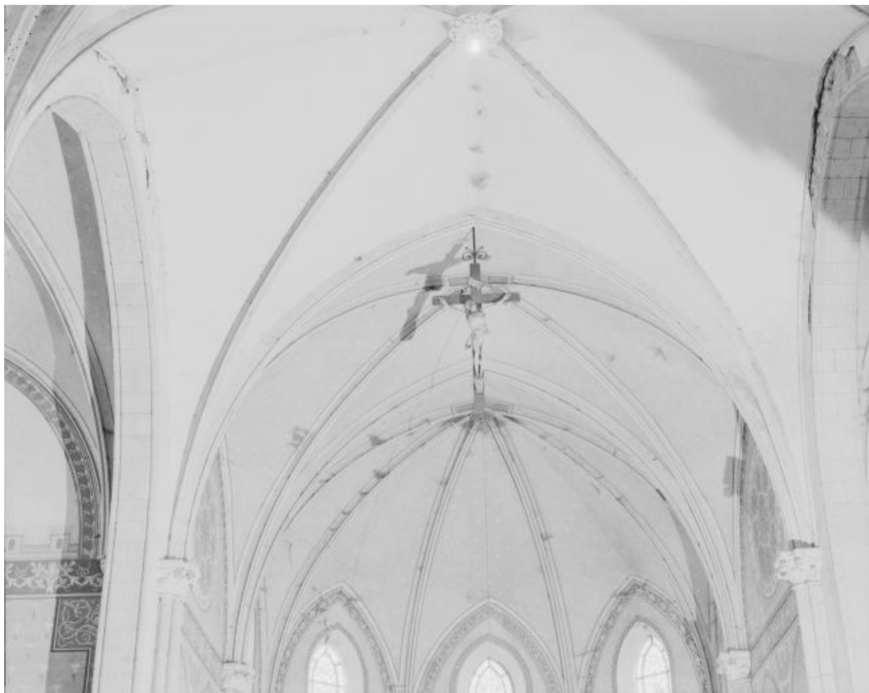
Vue générale en contre-plongée.
