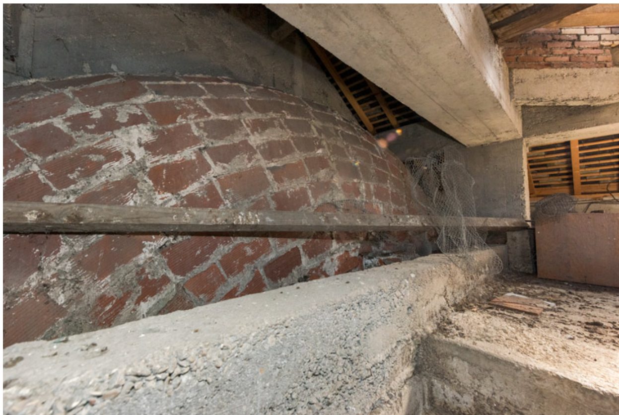
Voûte et charpente.
