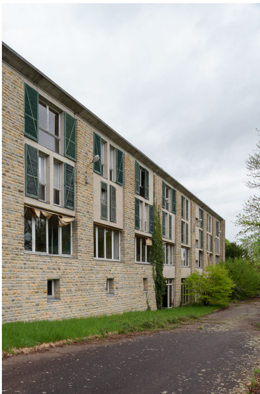
Élévation extérieure du corps de bâtiment principal.
