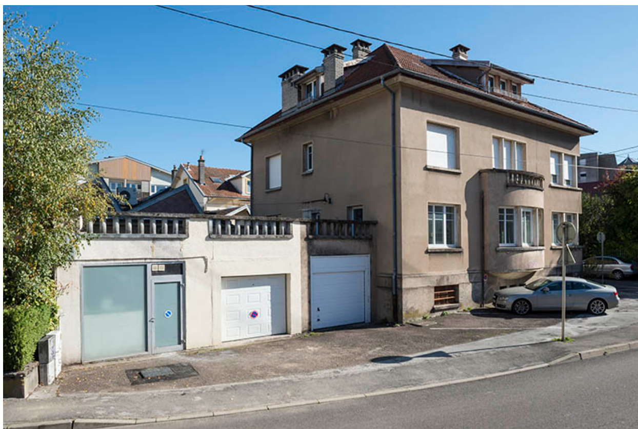
Garages et logement patronal.
