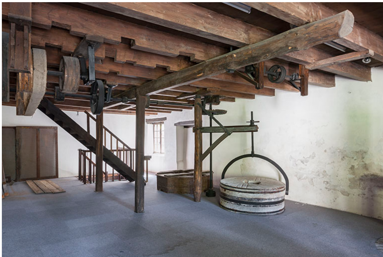
Premier étage. Vue d'ensemble depuis l'ouest.
