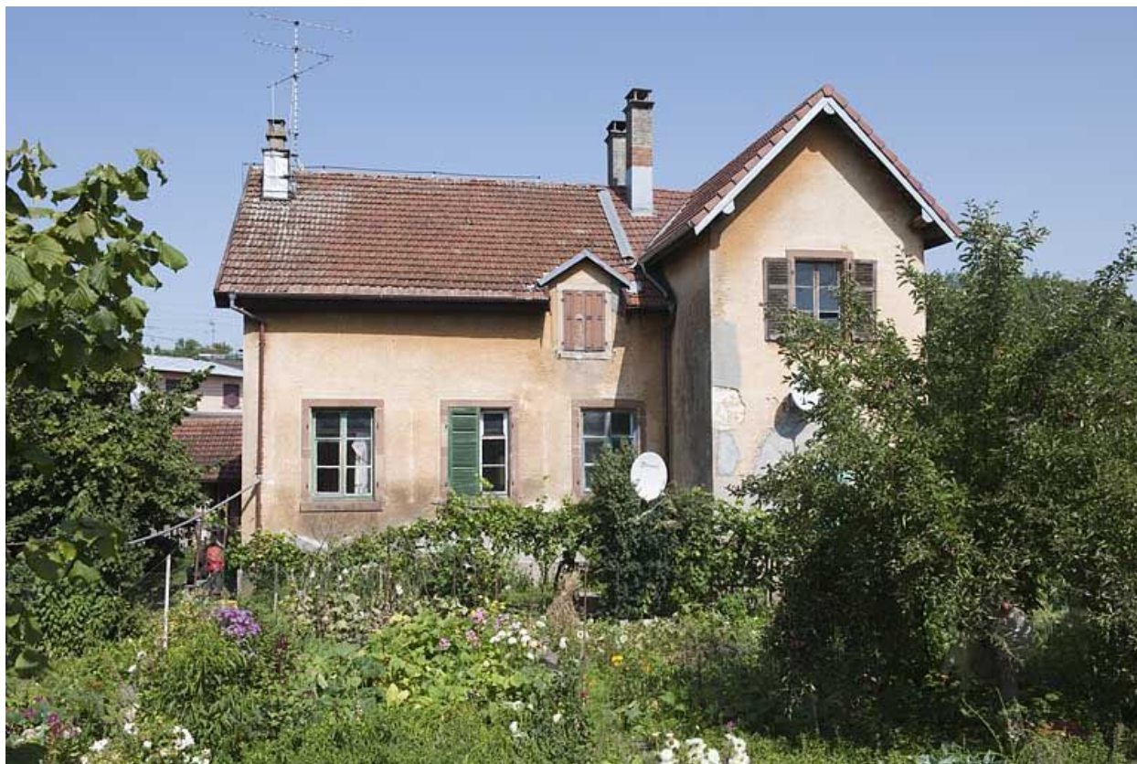
Façade sud de l'école.
