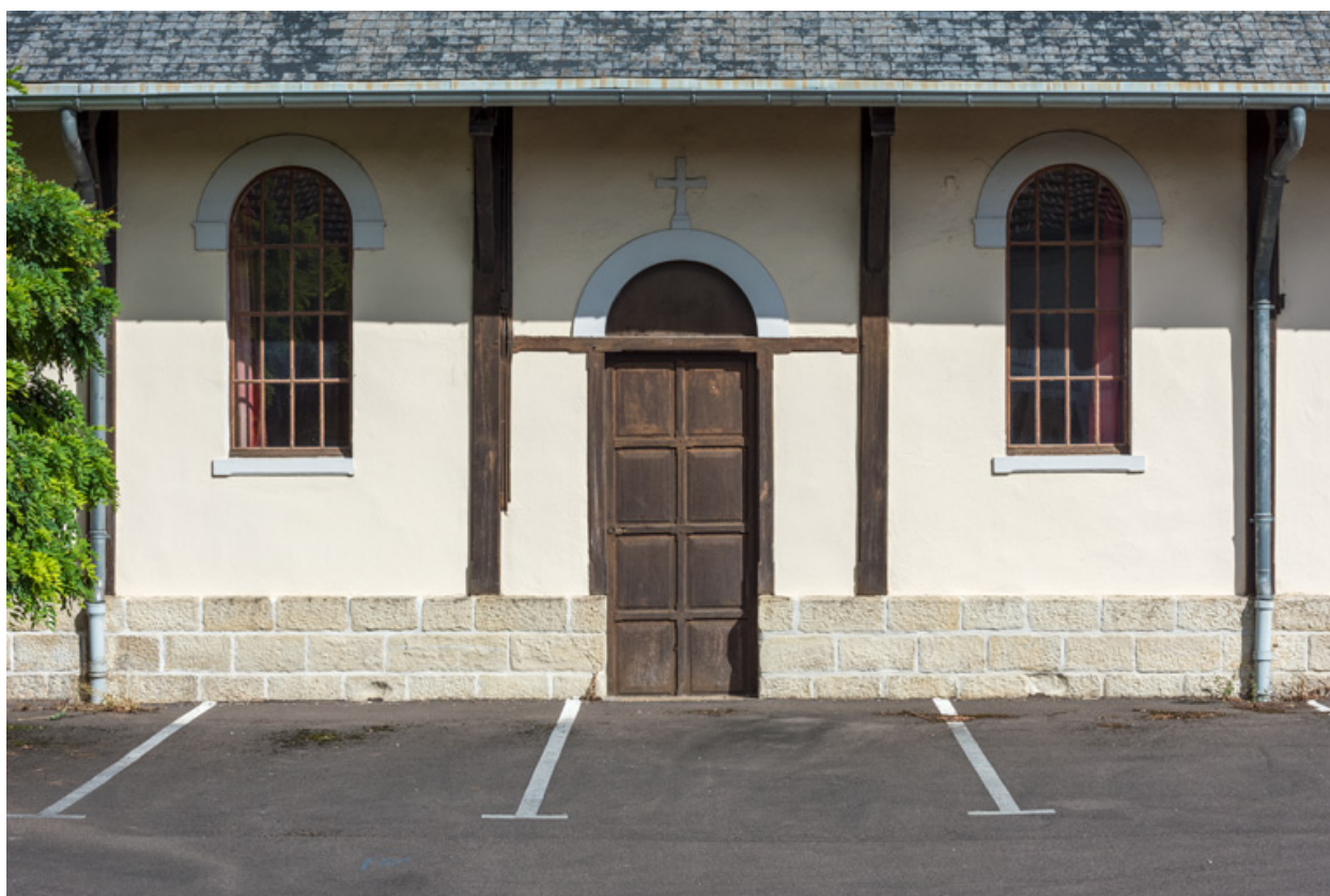
Façade ouest. Vue de trois travées.
