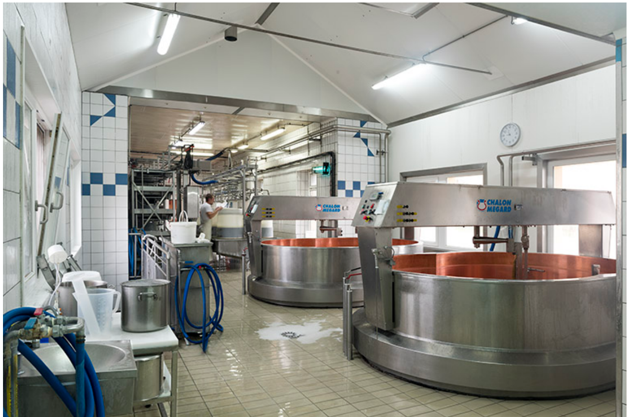
Atelier de fabrication : cuves à comté.
