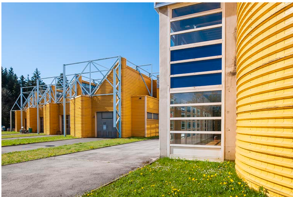
Atelier : façades Nord, détail
