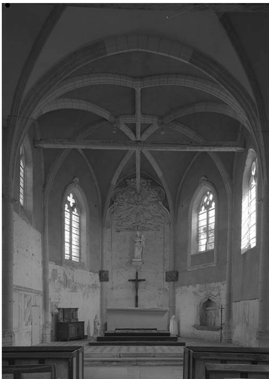
Choeur avec voûte d'ogives. Peinture monumentale.
