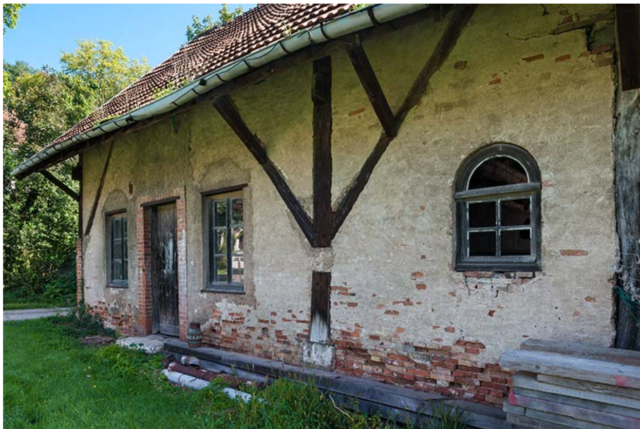
Détail de la façade ouest du magasin.
