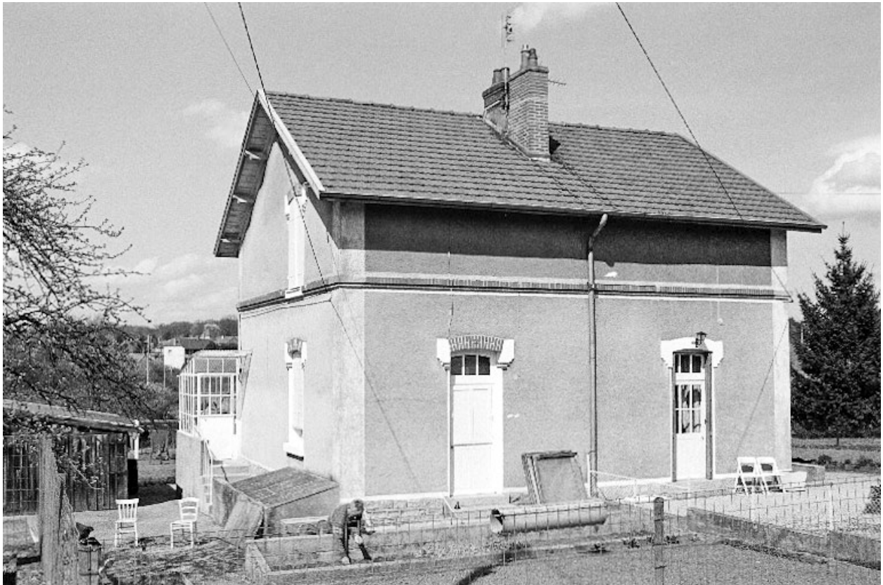
Bâtiment à 2 logements " type 8 ", 1938-1939.
