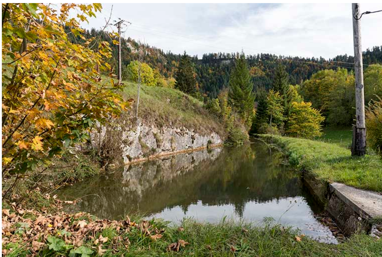
Bassin de retenue.
