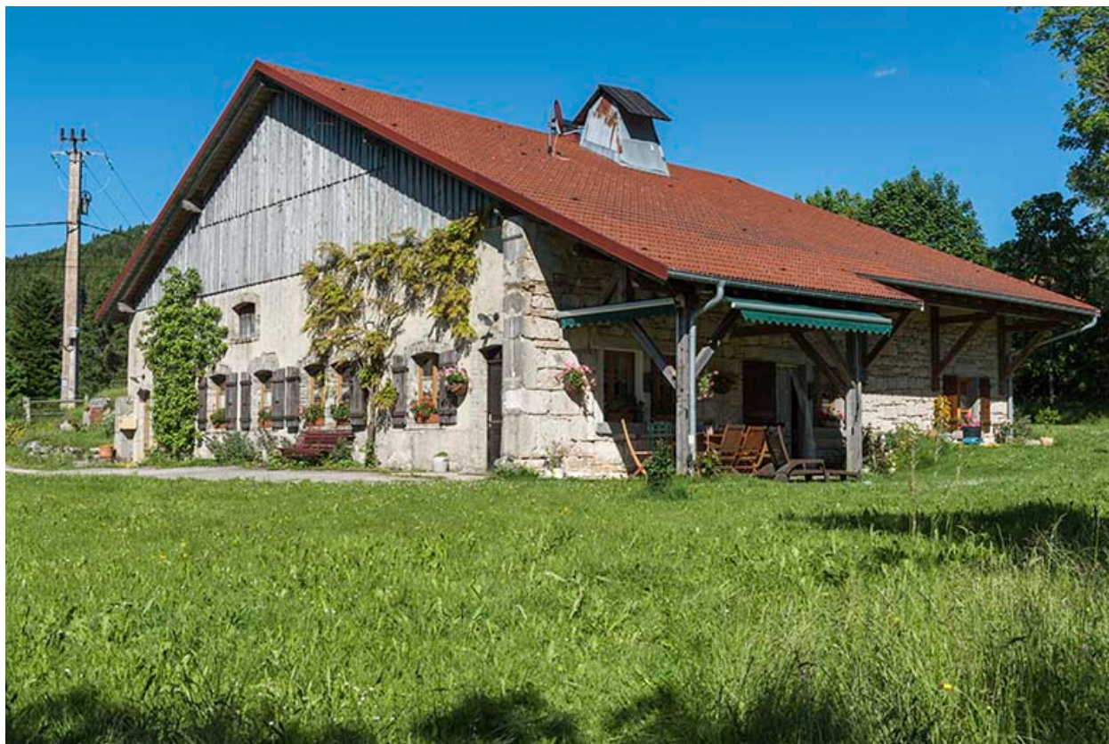
Façades antérieure et latérale droite.
