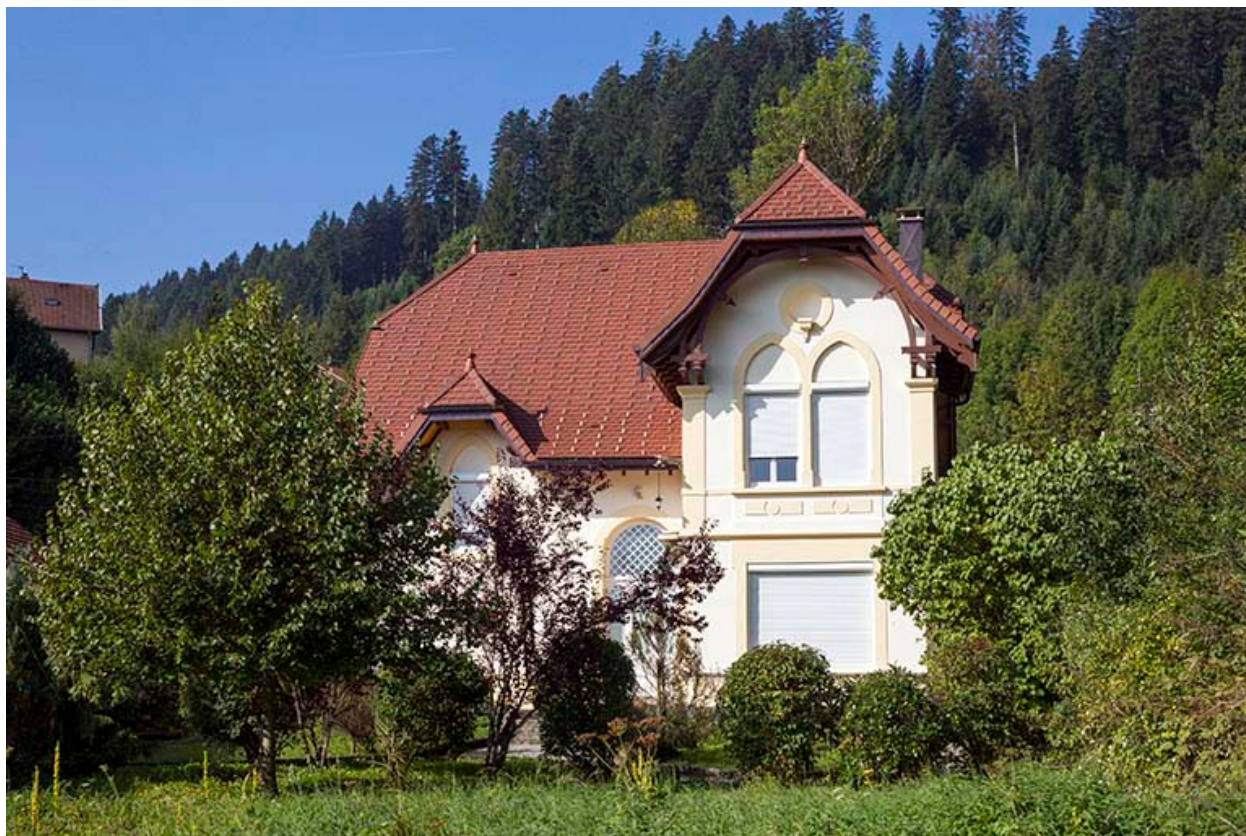
Logement patronal : façade occidentale.
