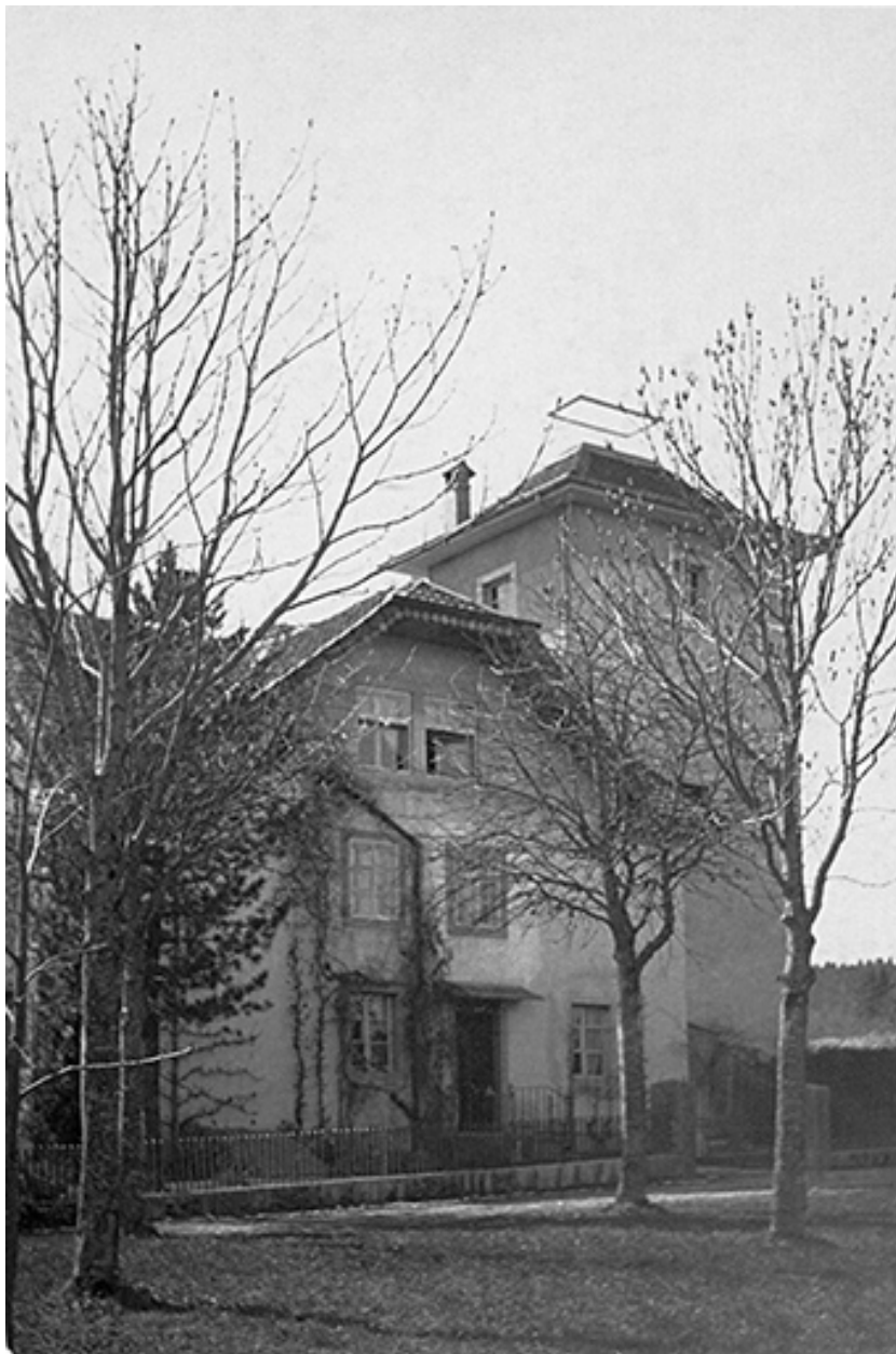
[La maison : façade latérale droite], 1936.
