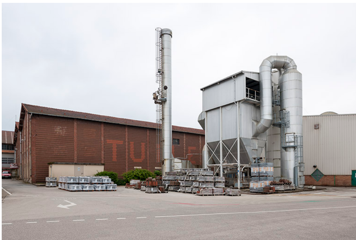
Atelier de fabrication (actuellement UL 3).
