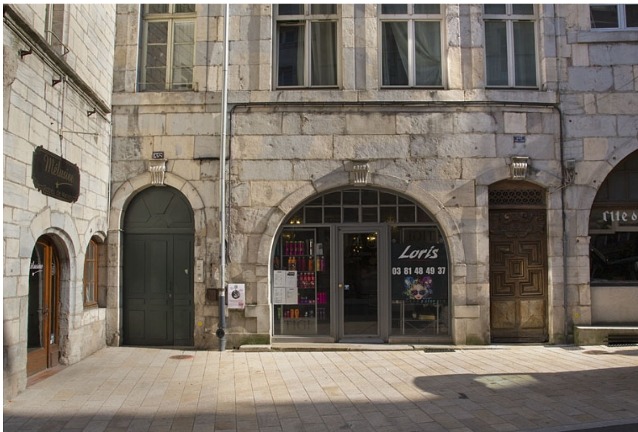
Façade antérieure : détail du rez-de-chaussée.
