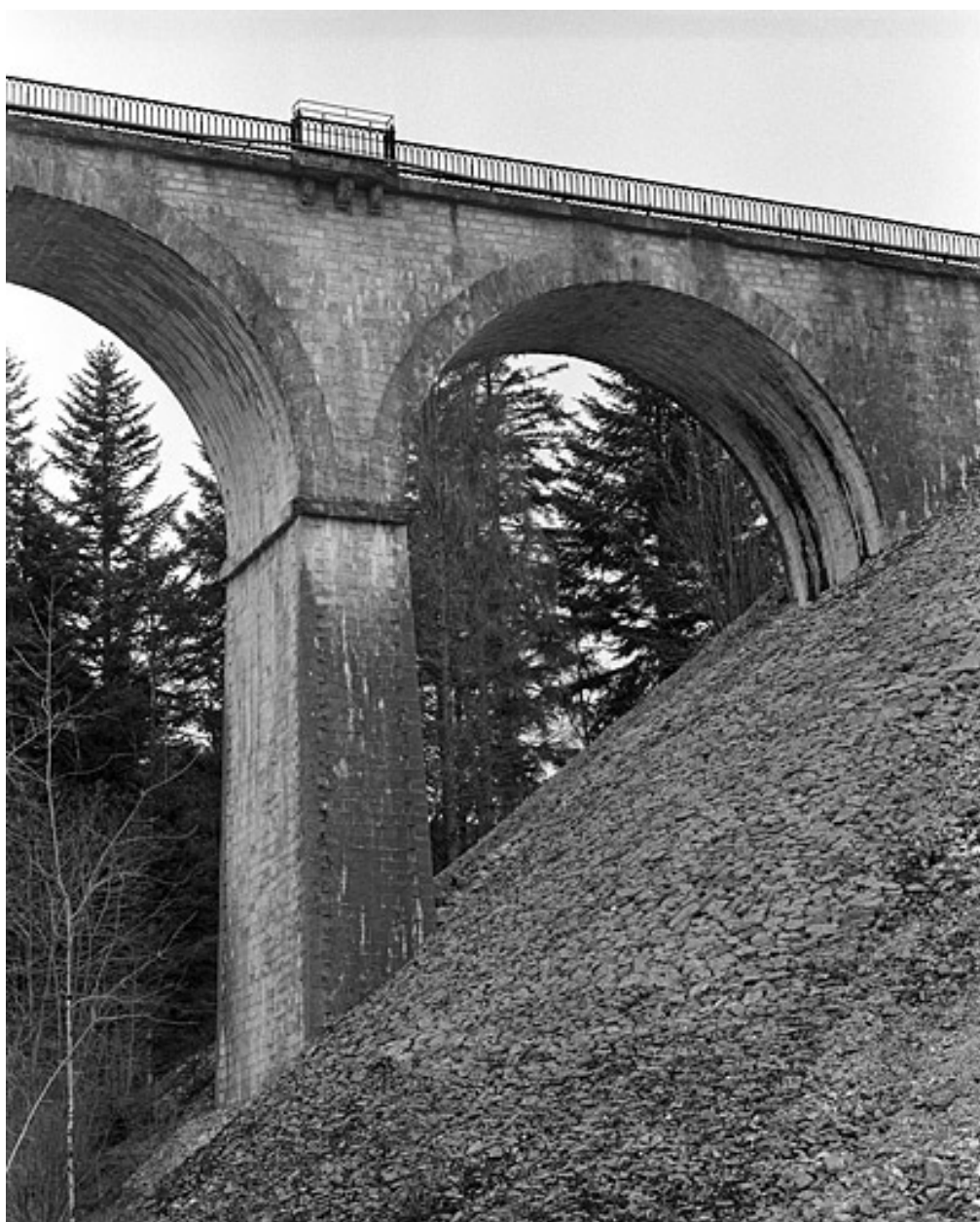
Première arche côté Andelot-en-Montagne, depuis l'est.
