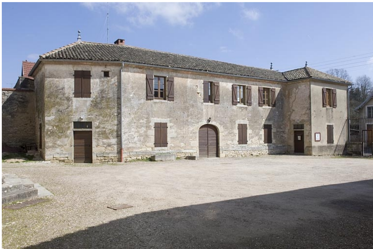
Logement patronal (31 rue Carnot). Dépendance nord.
