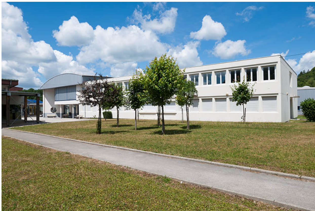
Ateliers, façade Sud.
