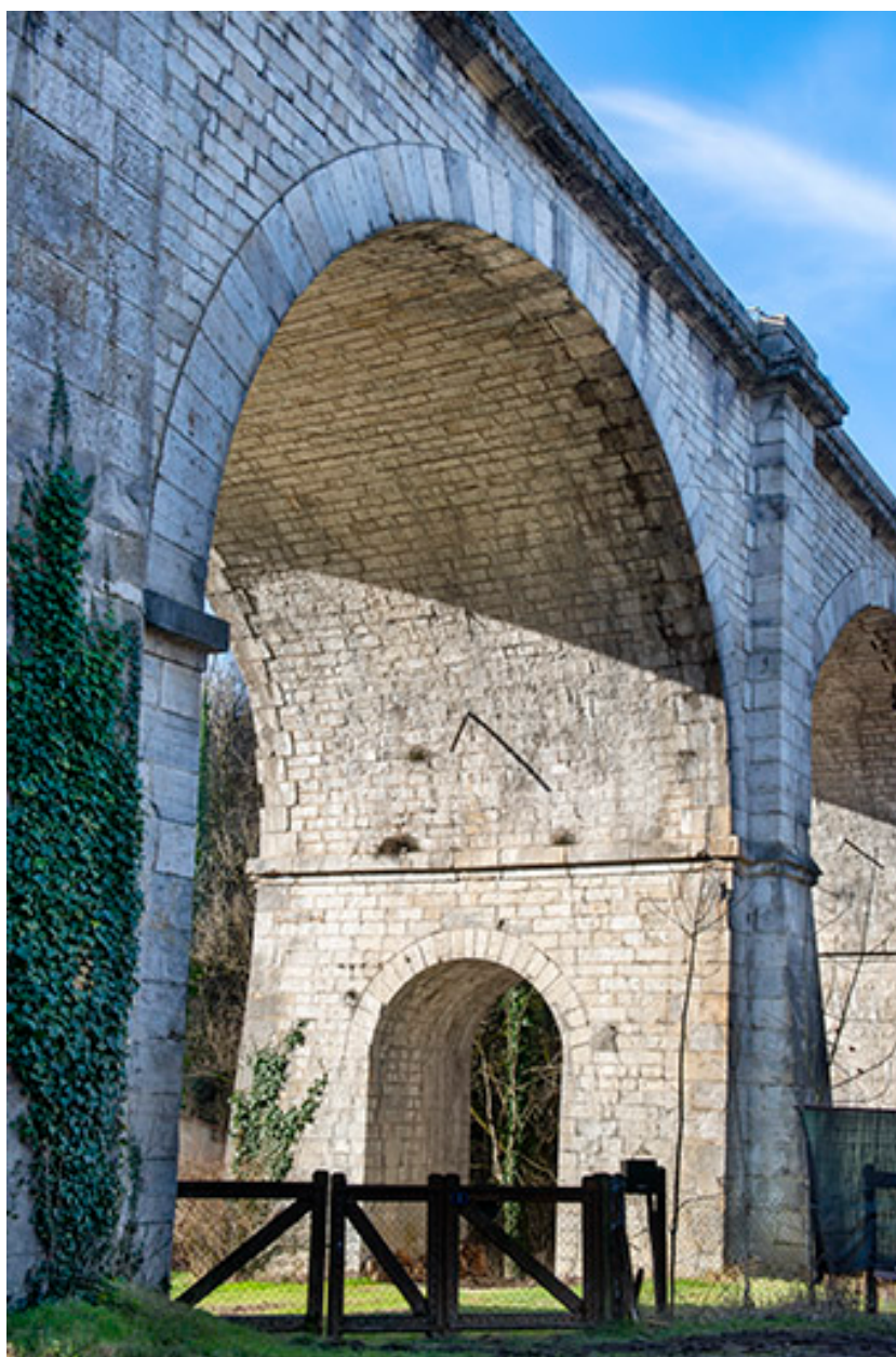
Vue rapprochée de l'arche est.
