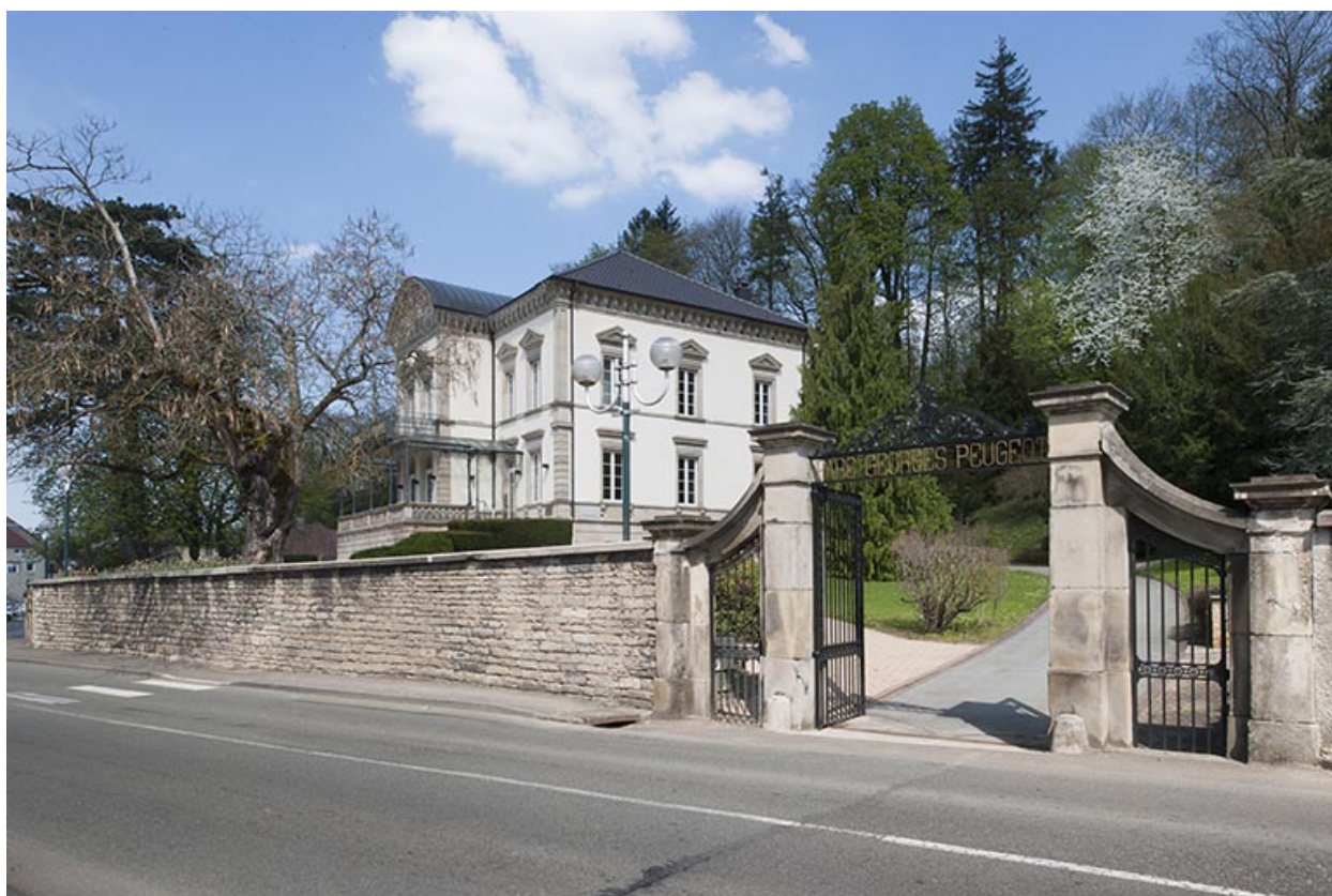
Vue rapprochée depuis le sud-ouest.
