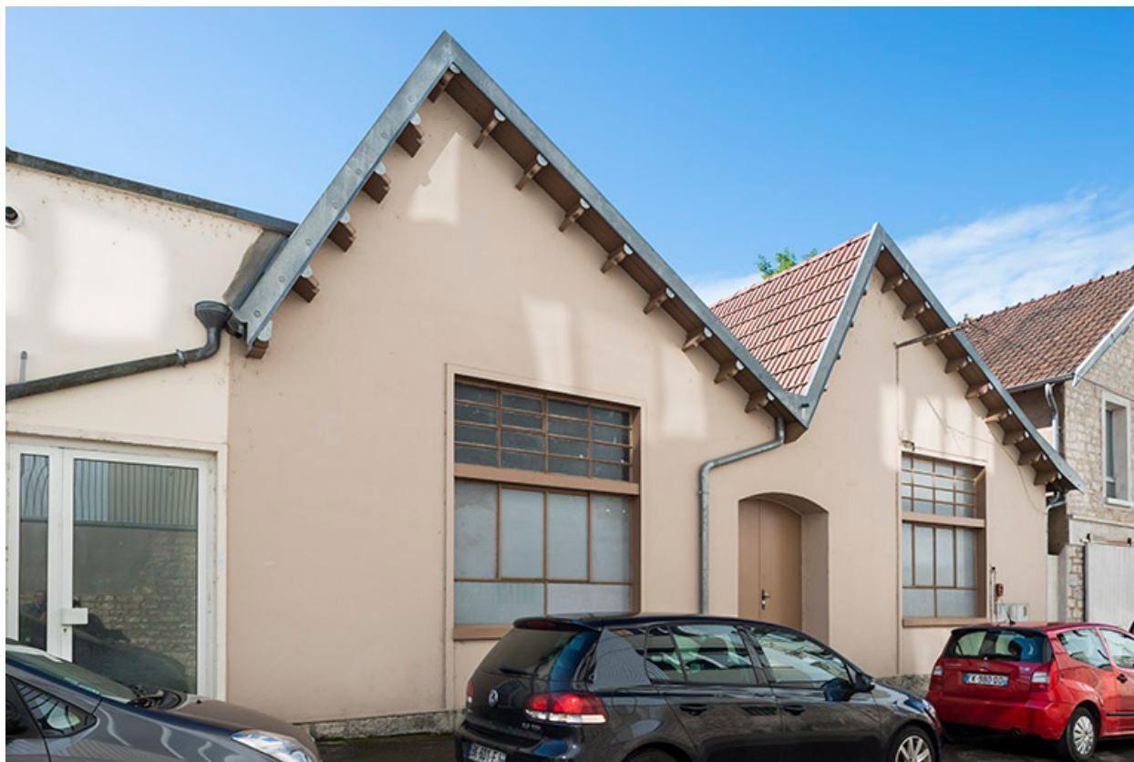
Murs-pignons des sheds sur le rue Klein.
