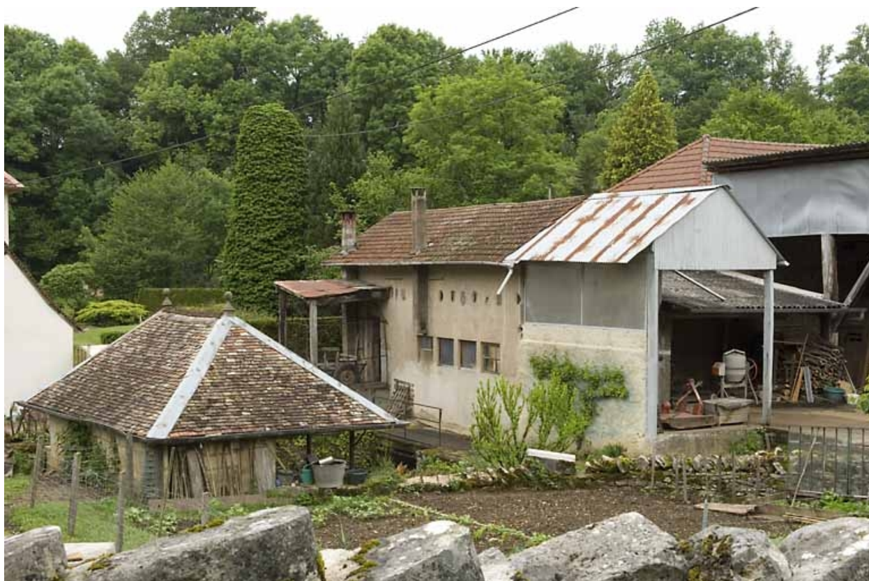
Les bâtiments industriels depuis le sud-est.
