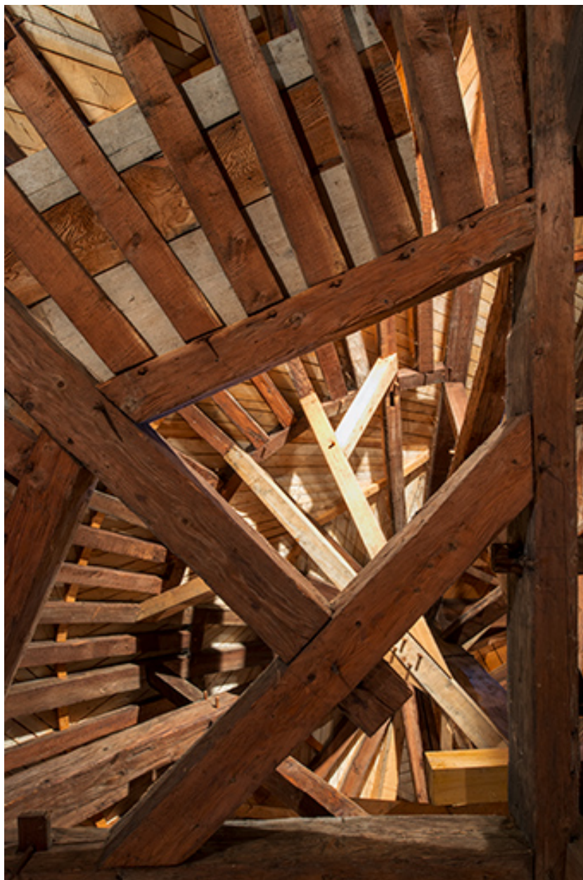
Enrayure nord-est de la charpente du dôme.
