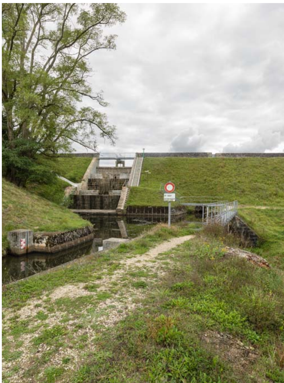
Vue du déversoir.
