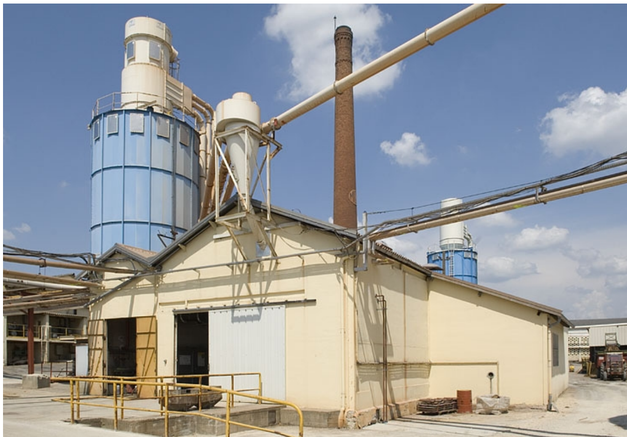
Salle des machines et chaufferie.
