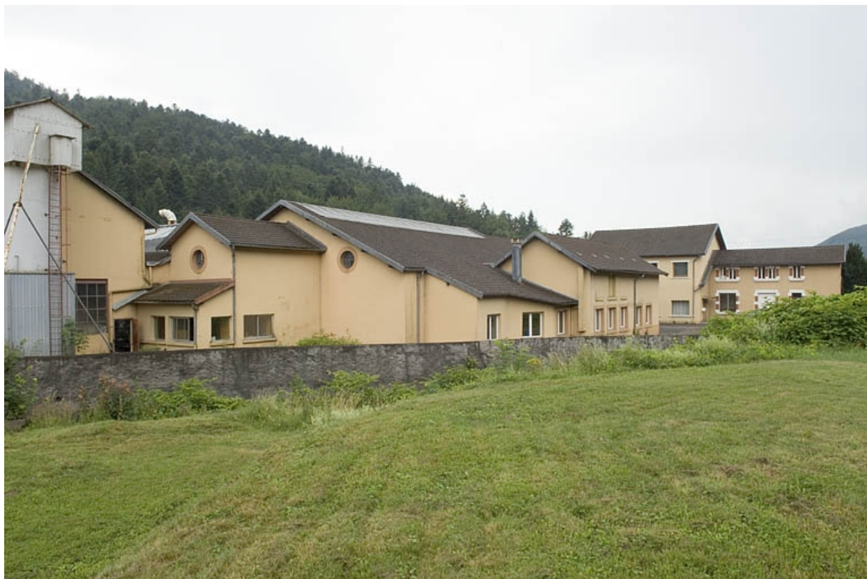
Ateliers de fabrication depuis le nord.
