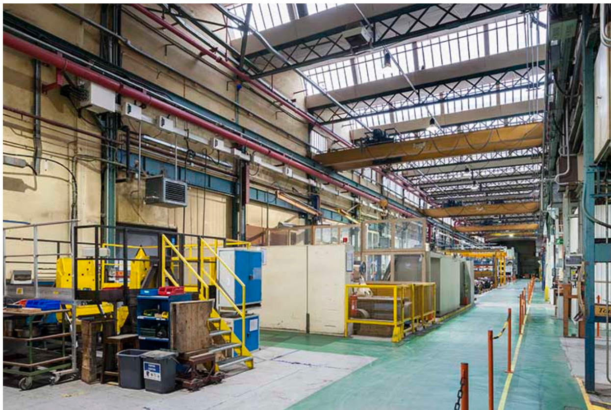
Hall central. Vue de côté.
