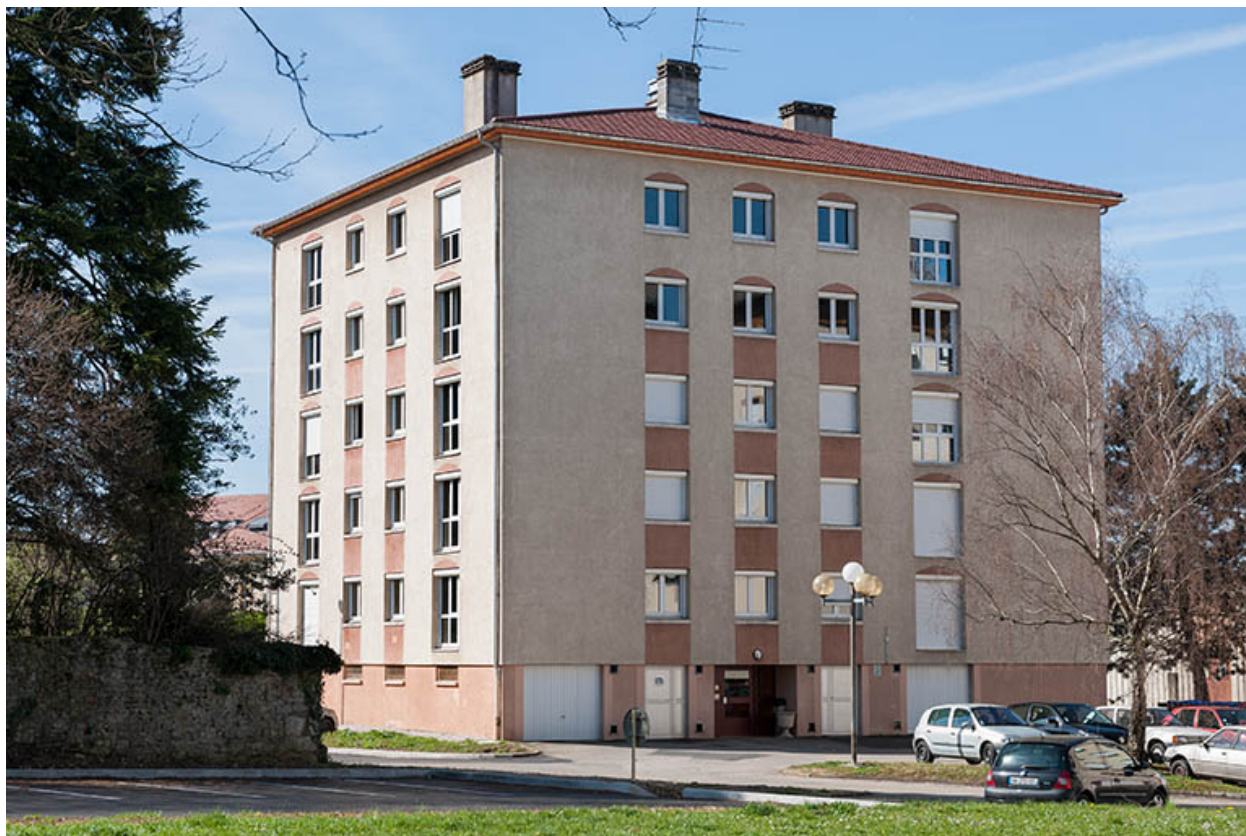
Angle nord-est, entrée du bâtiment des pinsons.
