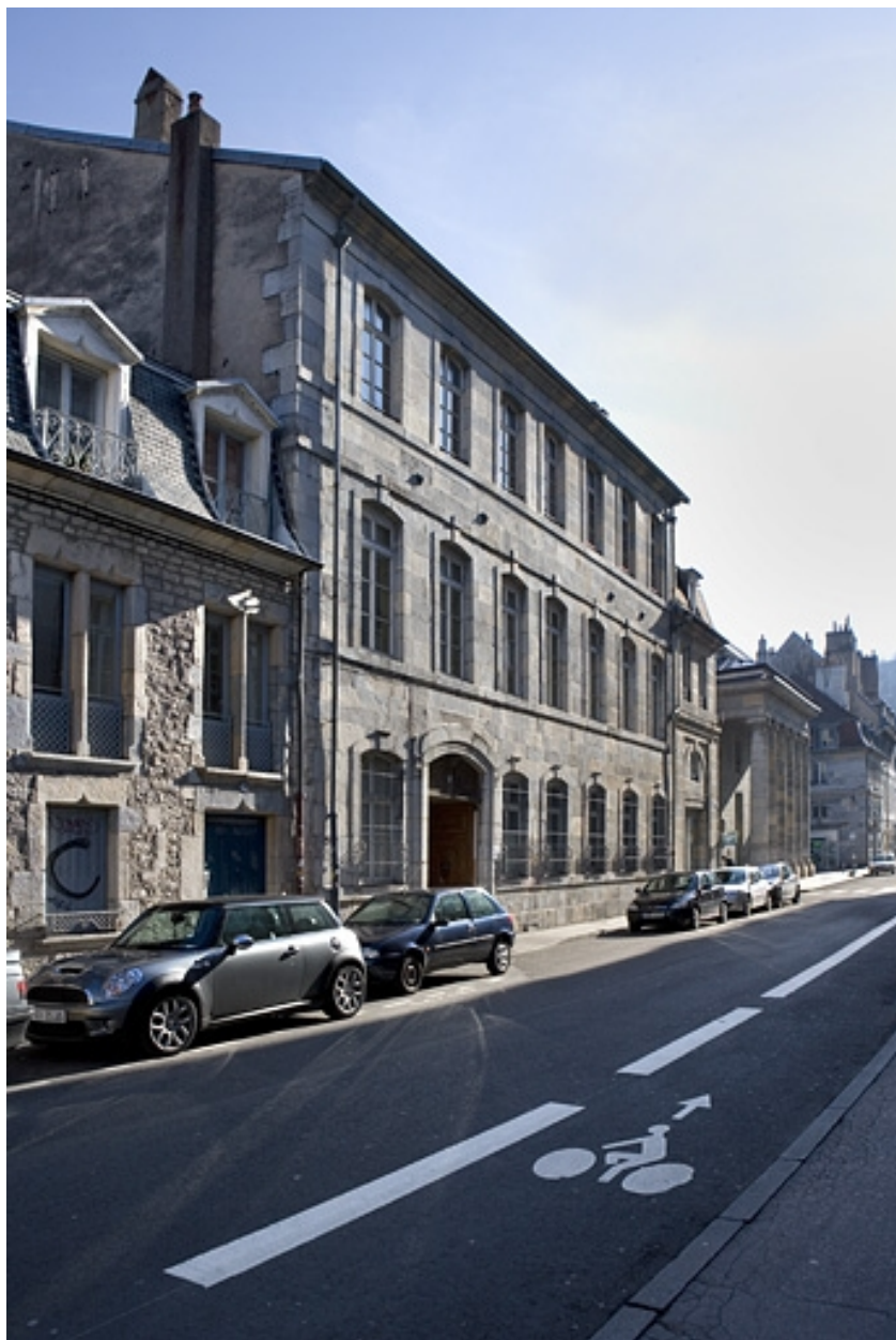
Vue d'ensemble rapprochée de la façade antérieure.
