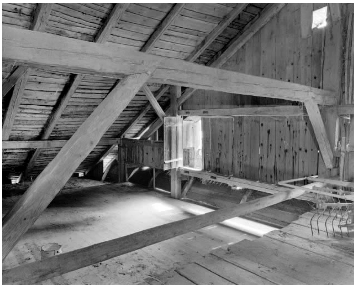
Charpente et lambrequerie antérieure à surplomb cintré.
