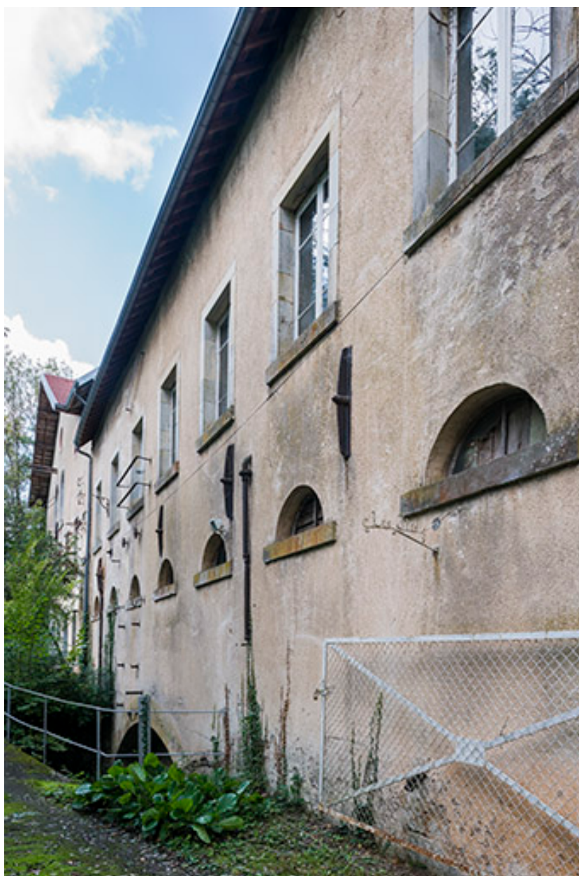
Façade antérieure. Vue depuis l'entrée.
