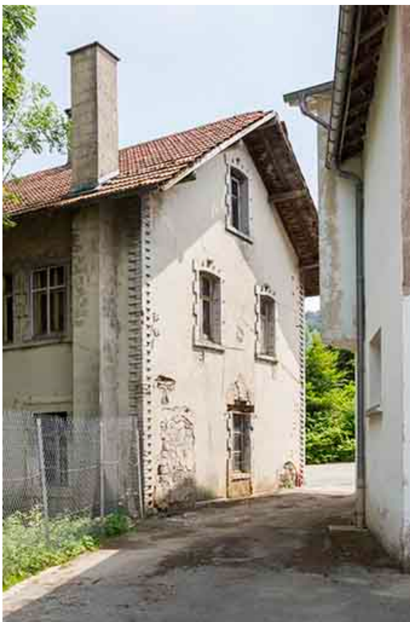
Atelier de fabrication occidental : mur pignon ouest.
