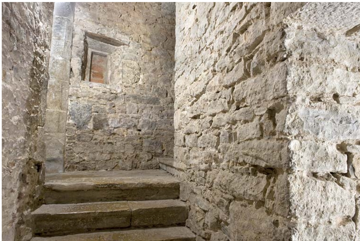
Escalier dans-oeuvre desservant les étages.
