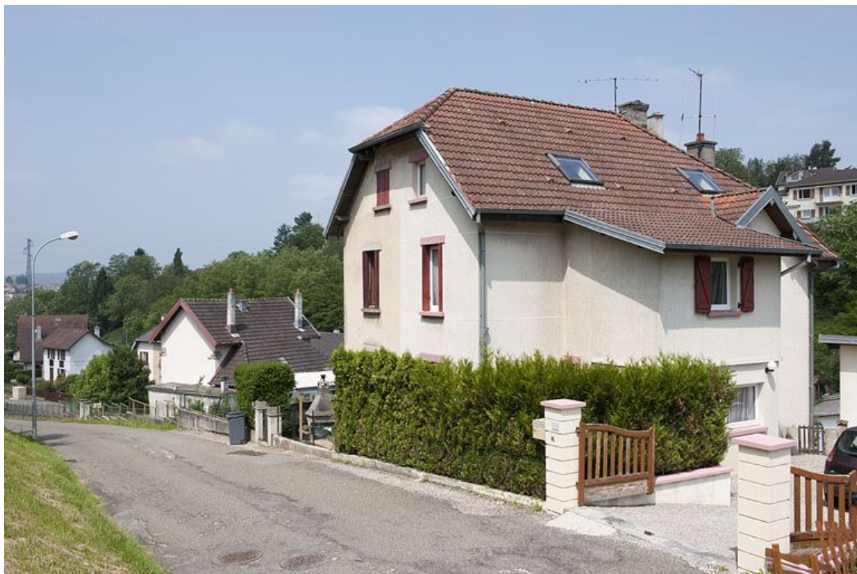
Maison jumelée. Vue de trois quarts droite.
