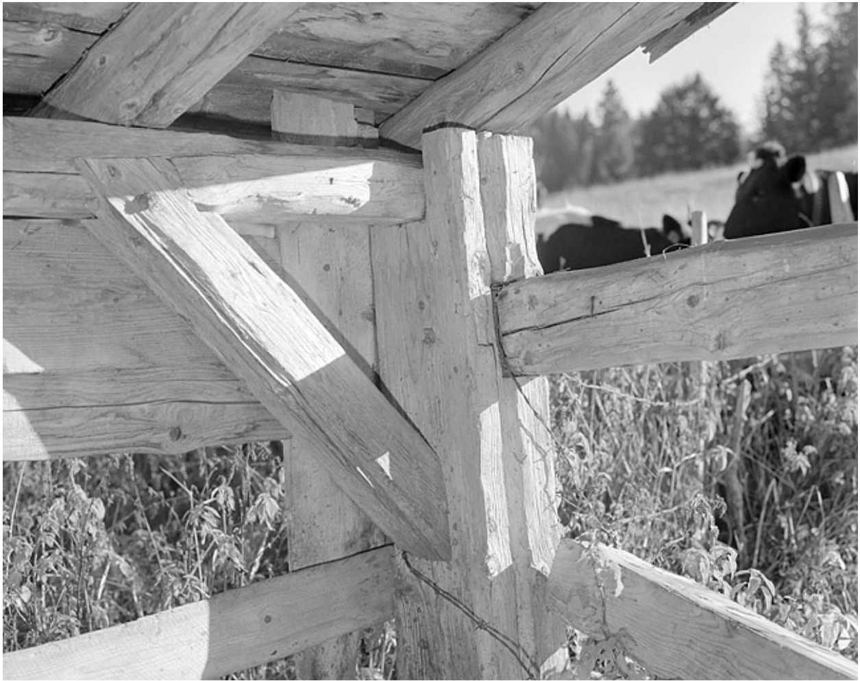
Assemblage de la charpente de l'abreuvoir.
