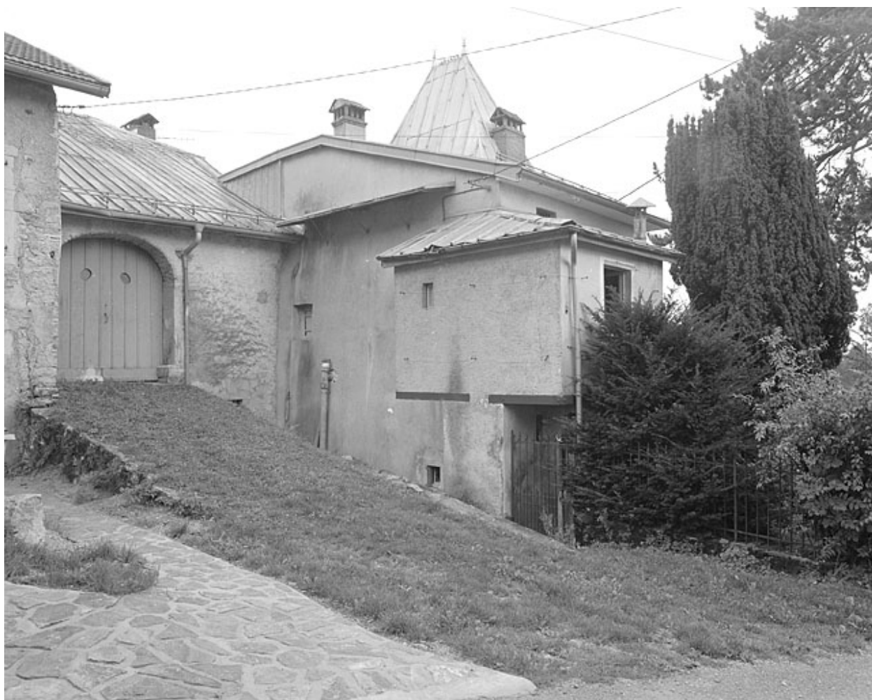
Façade postérieure de la demeure.
